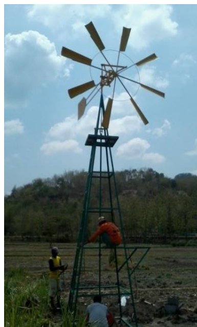
Gambar 1 Rancangan pompa PVC dan proses pemasangan kincir angina.
